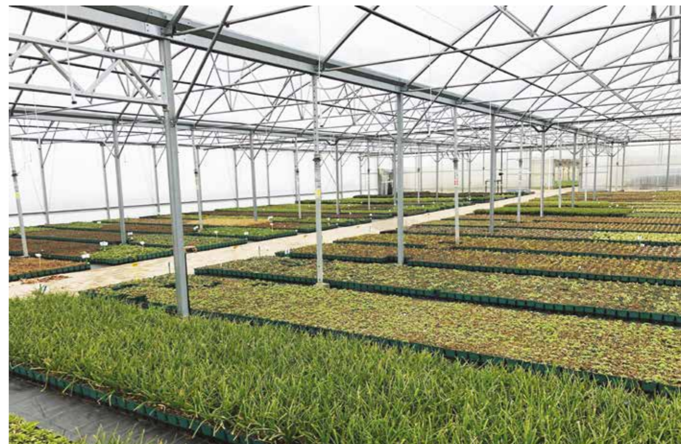
Début février 2021, après un avis de tempête, notre sociétaire Schachtschneider Stauden, producteur de plantes vivaces à Döttingen (près de Brême, Allemagne du nord) a installé 250 étais métalliques pour sécuriser ses serres multi-chapelles.
