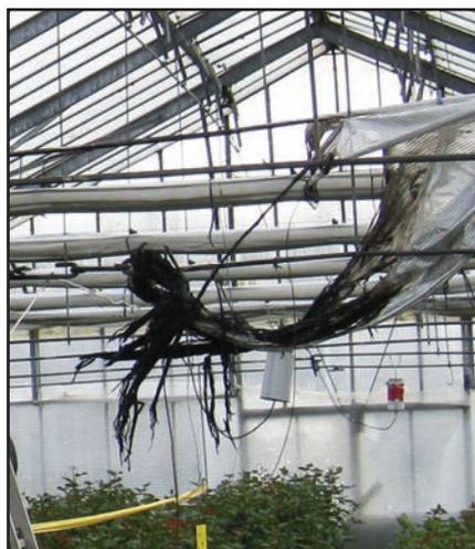
**Image ci-dessus :** un évaporateur à soufre a enflammé les écrans d'ombrage. Dans ce type de situation, Gartenbau-Versicherung recommande d'utiliser un écran difficilement inflammable et de respecter une distance suffisante avec les appareils.
