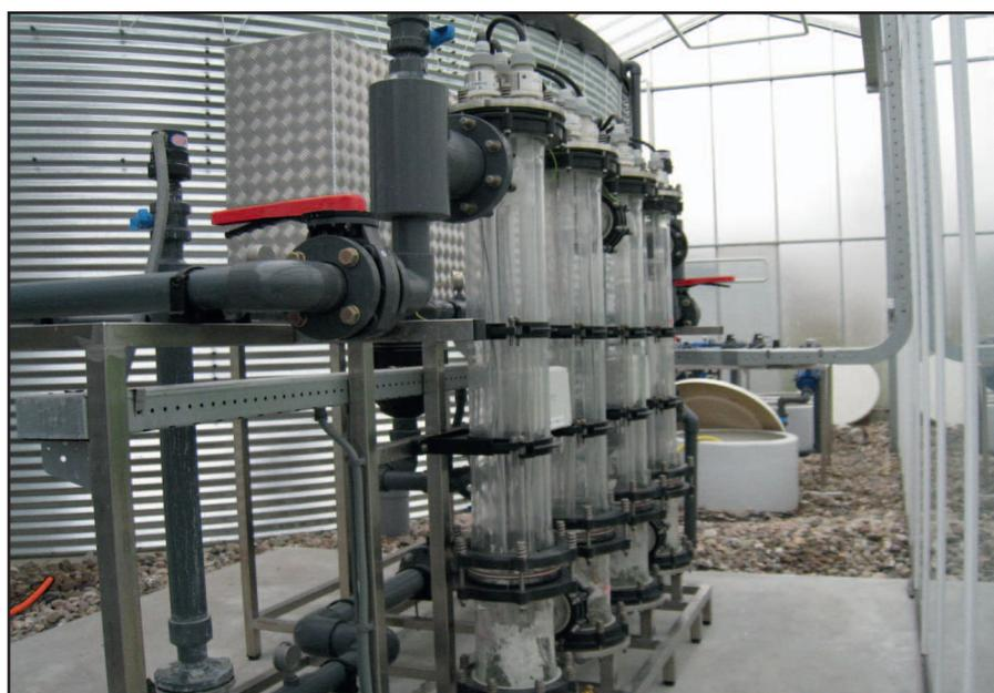
Photo 1: Installation de traitement aux rayons UV
