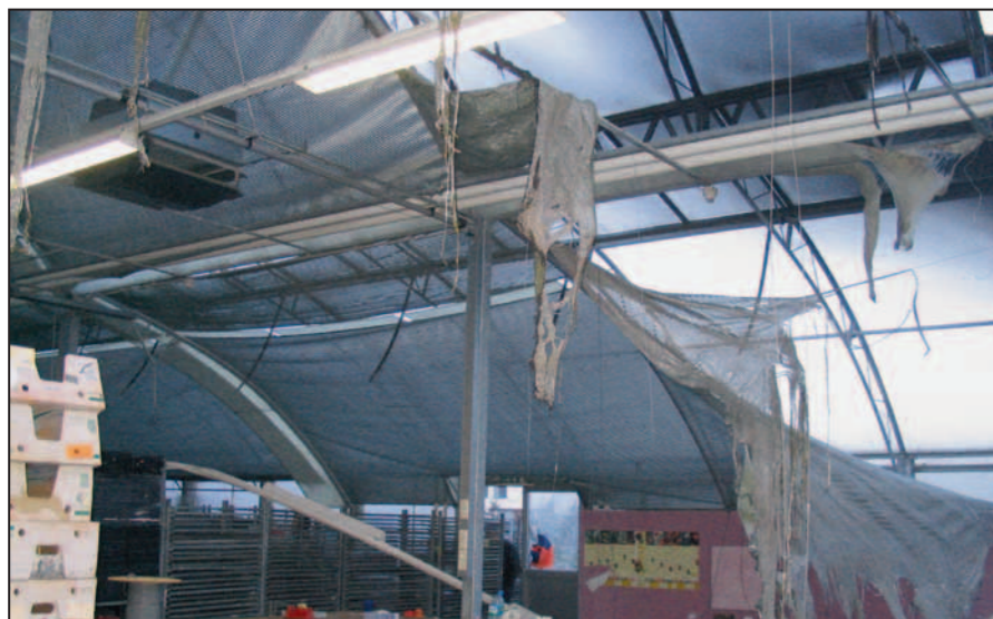
Photographie 1 : Effet positif d'une toile d'ombrage difficilement inflammable sous verre Sécurité (simple vitrage).
