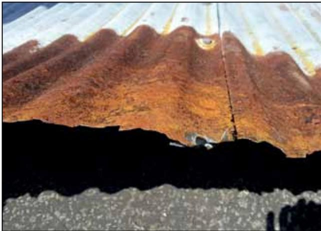
Photographie n° 3 : Rouille importante à l'intérieur des tôles ondulées déchirées
